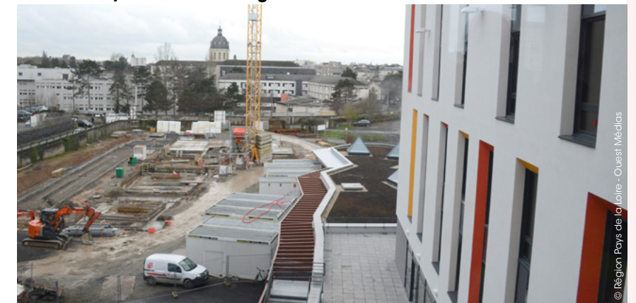
Chantier du lycée Wresinski à Angers
